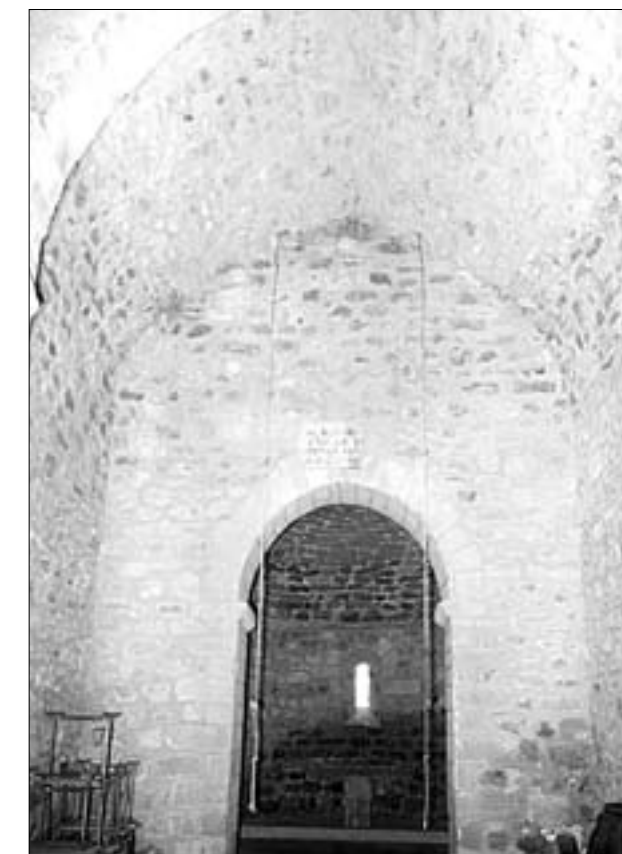
El interior de la ermita de Santa Fe está cubierto con bóveda de cañón sobre arcos fajones. La estrechez del arco triunfal enlaza con la tradición constructiva mozárabe. En la imagen de la derecha se aprecia como el anteábside y el ábside son de distinta anchura y están cubiertos con bóvedas de cañón y horno
